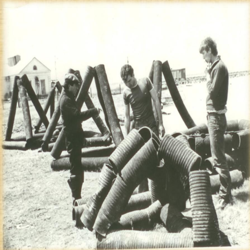
Построение донных модулей из обрезков рыбонасосных шлангов в Сулакской бухте
